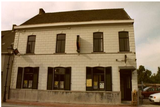
De Markoen in 2003, de gebouwen links waren toen al gesloopt.
